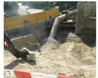
01 Provisorium Werkleitungen 02 Nagelwand zur Böschungssicherung 03 Bauen unter Aufrechterhaltung des Verkehrs
