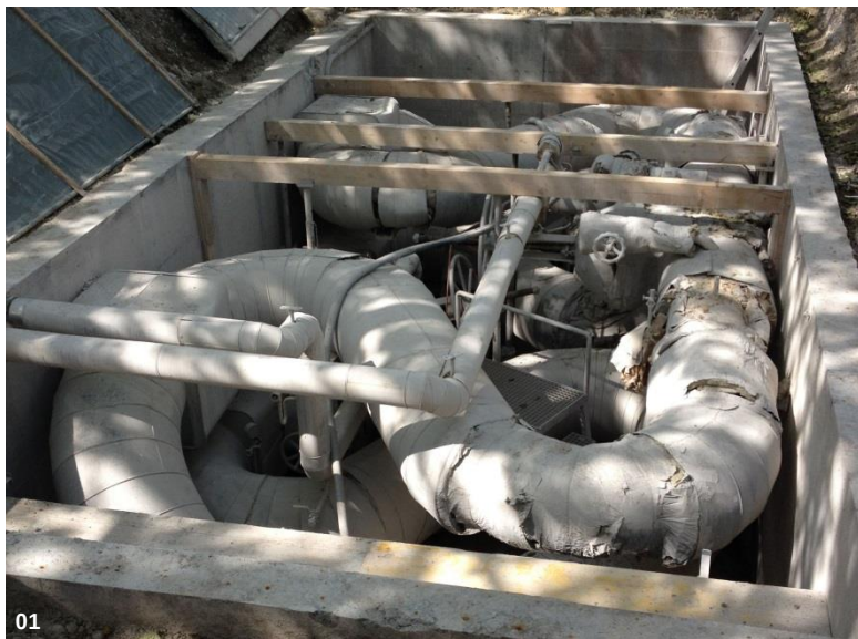
01 Alte Fernwärmekammer mit Notspriessung 02 Systemschalung Kammer 03 Neue Kammer mit Fernwärmehauptleitung
