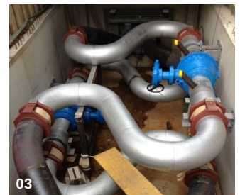
01 Alte Fernwärmekammer mit Notspriessung 02 Systemschalung Kammer 03 Neue Kammer mit Fernwärmehauptleitung
