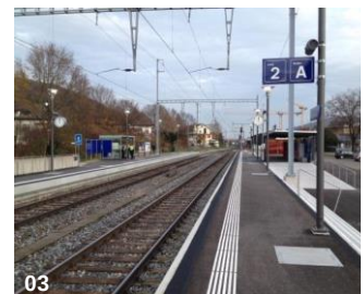
01 Umbau Aussenperron 02 Gleisentwässerungs- und Perronarbeiten 03 Erneuerter Perron- und Gleisbereich
