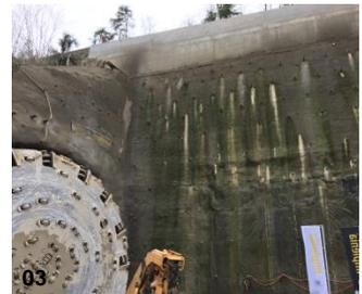
01 Voreinschnitt während des Durchstichs 02 Voreinschnitt 20016 03 Ansicht an Nagelwand und Stützkonstruktion Bahnhofstrasse
