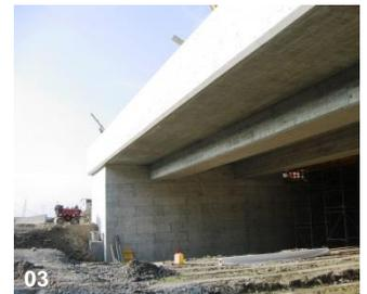
01 Integrale Rahmenkonstruktion 02 Detail Ankerköpfe 03 Detail Plattenbalken mit zwei Stegen
