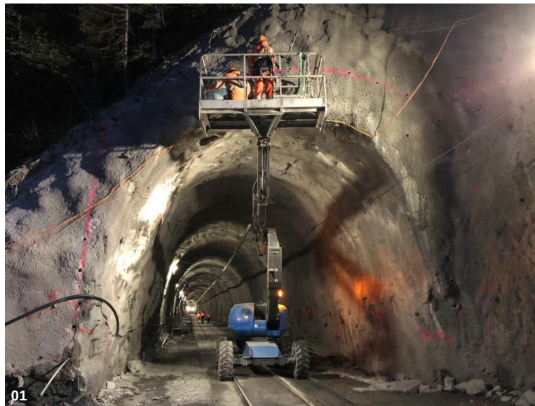
01 Ausgeweitetes und gesichertes Profil 02 Portal Seite Solis kurz vor dem Abbruch 03 Provisorisches Betriebsgleis, als feste Fahrbahn auf Sohlplattenelementen
